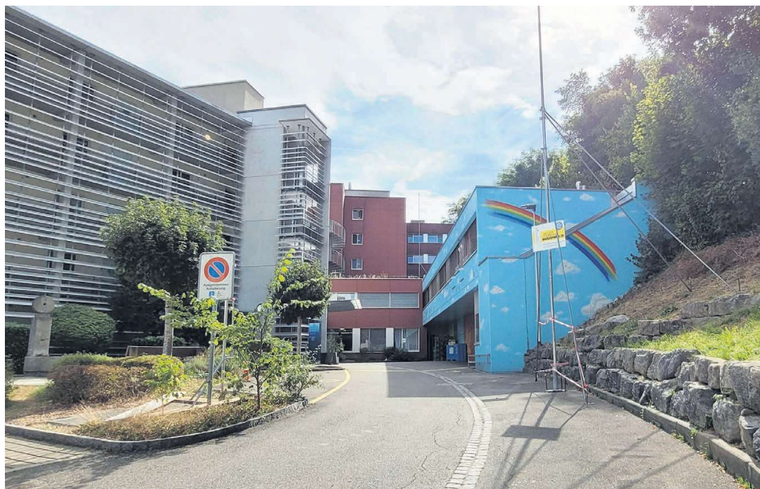
Die Profilstangen zeigen es deutlich: Der neue Annexbau wird länger und vor allem höher. Er ist nach Fertigstellung sogar ganz wenig höher als das Hauptgebäude.
